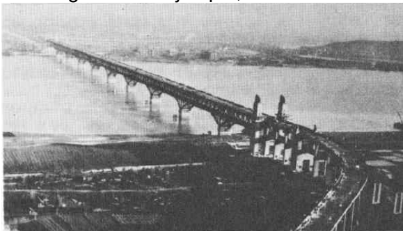
El puente sobre el río Yangtsé, en Nankín
